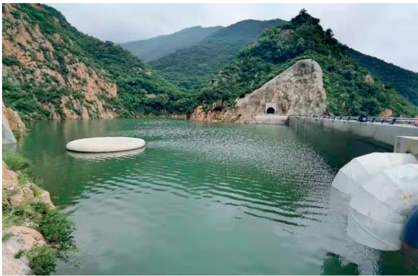
延庆赛区 A 部分场馆配套基础设施——造雪引水工程
