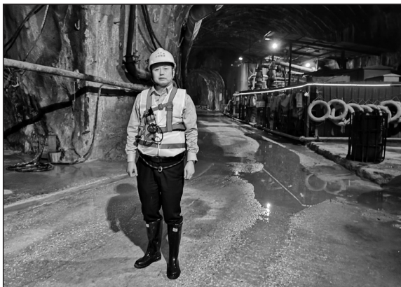
景来红在大瑞铁路高黎贡山隧道施工现场
